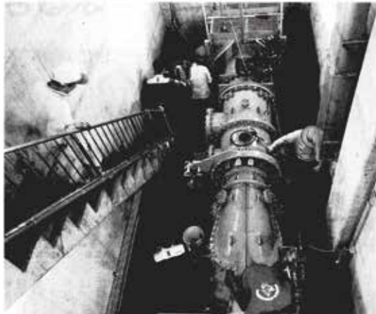
23年8月豪雨直後の発電機と水車。土砂の撤去作業に追われ、被災直後には地元産出の石炭産物議員（見目）も駆け付けた（鳥取市で別府電化農業協同組合提供）
