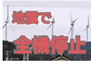
能登半島地震では73基の風力発電全てが停止した https://www.tokyo-np.co.jp/
