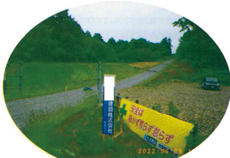
八ノ沢風力発電所工事用道路
