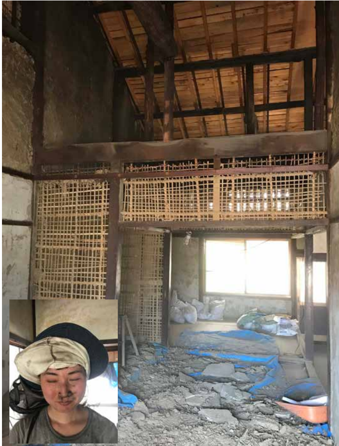
解体作業で顔中、塵まみれ
