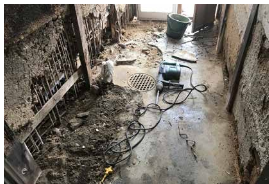
(下) 土間のはつり作業 (左) 解体作業壁剥し
