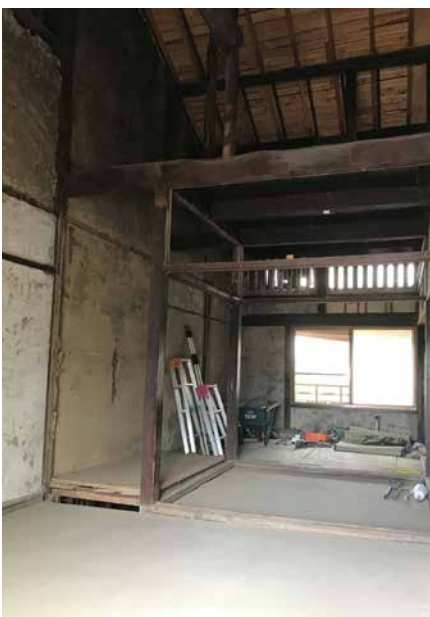
解体後の室内
