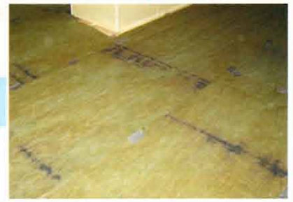
3 電磁波をカットするためスパンボンドを敷きます。
