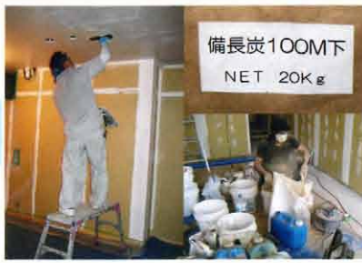
4 焼成ミネグリーンと、備長炭の粉末を床と壁の下地に混入。
