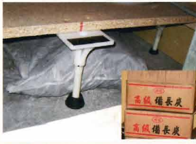
1 床下には、調湿と気の流れを良くするための備長炭を入れました。
